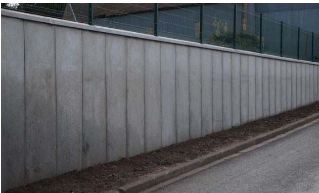
Photo d'un mur de soutènement sur voirie.
