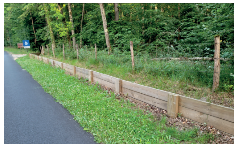
Barrière de protection le long d'une route
