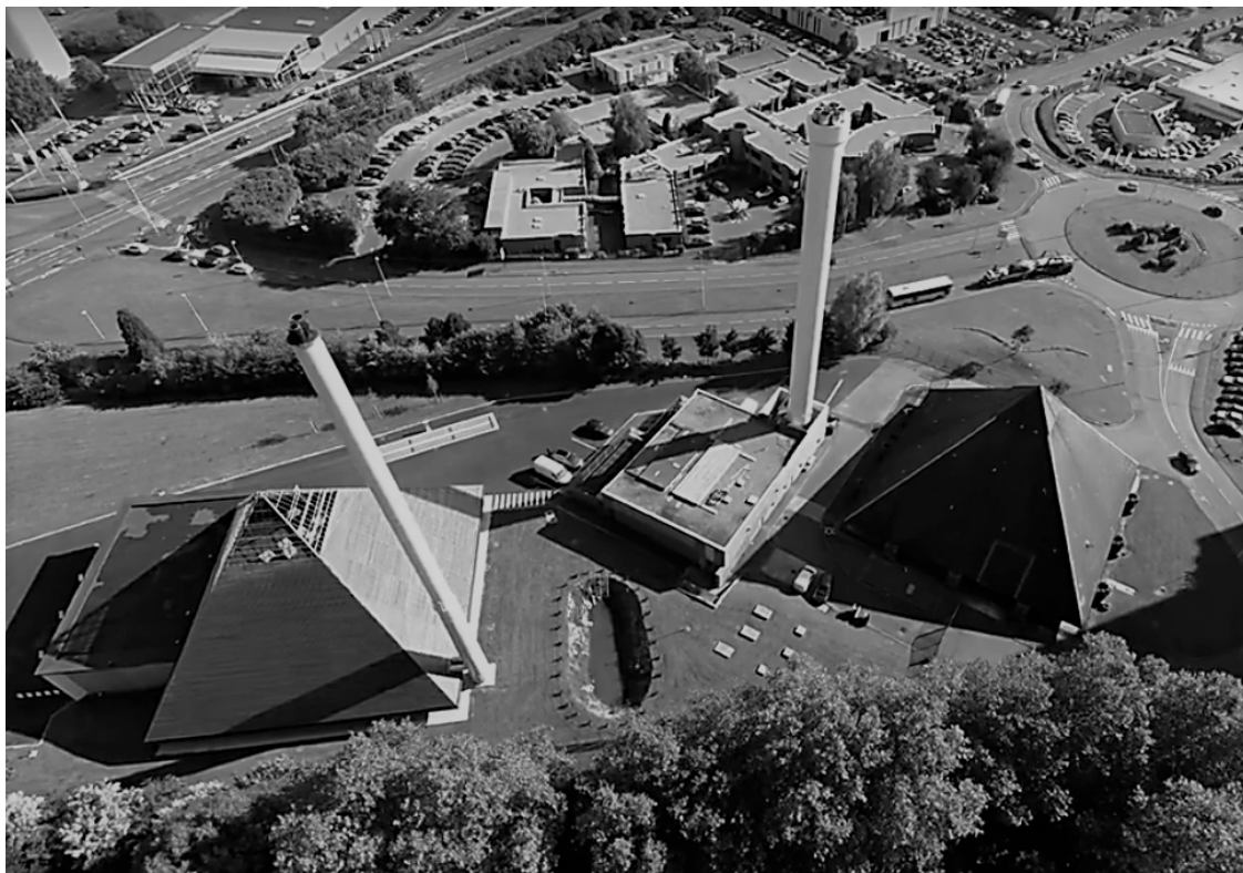
Figure 1 : chaufferie urbaine de Mons-en-Barœul
